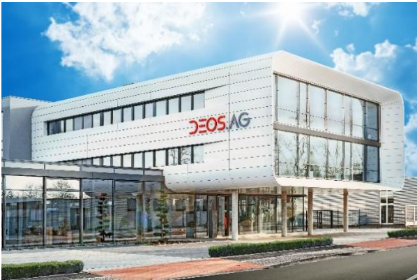
Abbildung 1: Zentrale der DEOS AG in Rheine
